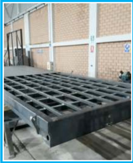
Fabricación de Plataforma
