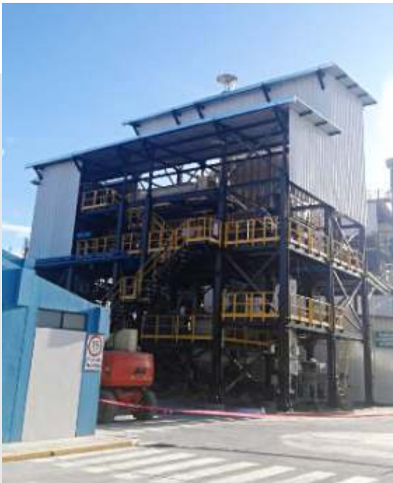
Fase inicial. Montaje de estructuras: Planta de Borato INKABOR.
